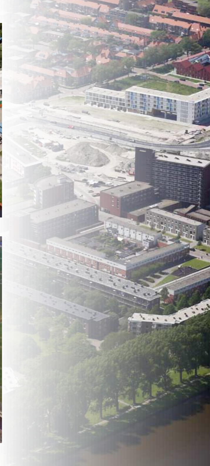
Aanleg Noordzeebrug Groningen >
