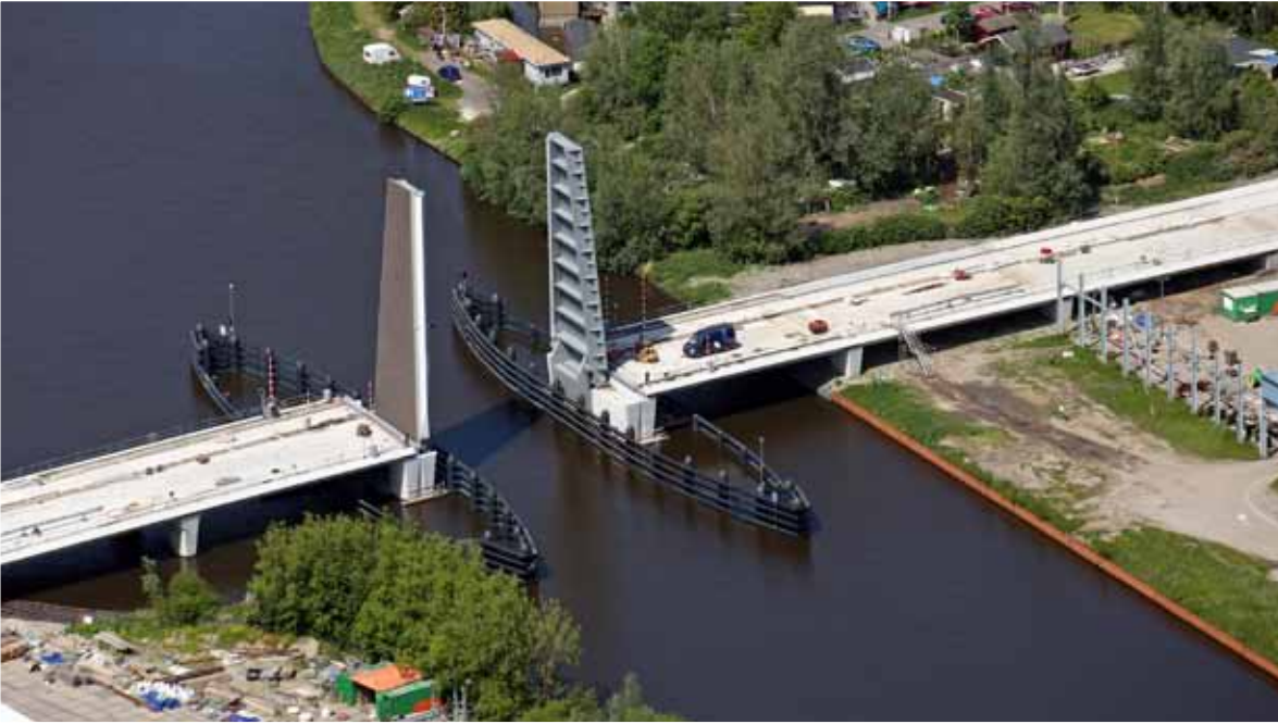
Aanleg Sontbrug o.i.d.? ▲
