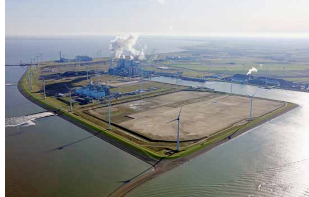
Van Merksteijn bouwlocatie toekomstige staalfabriek
