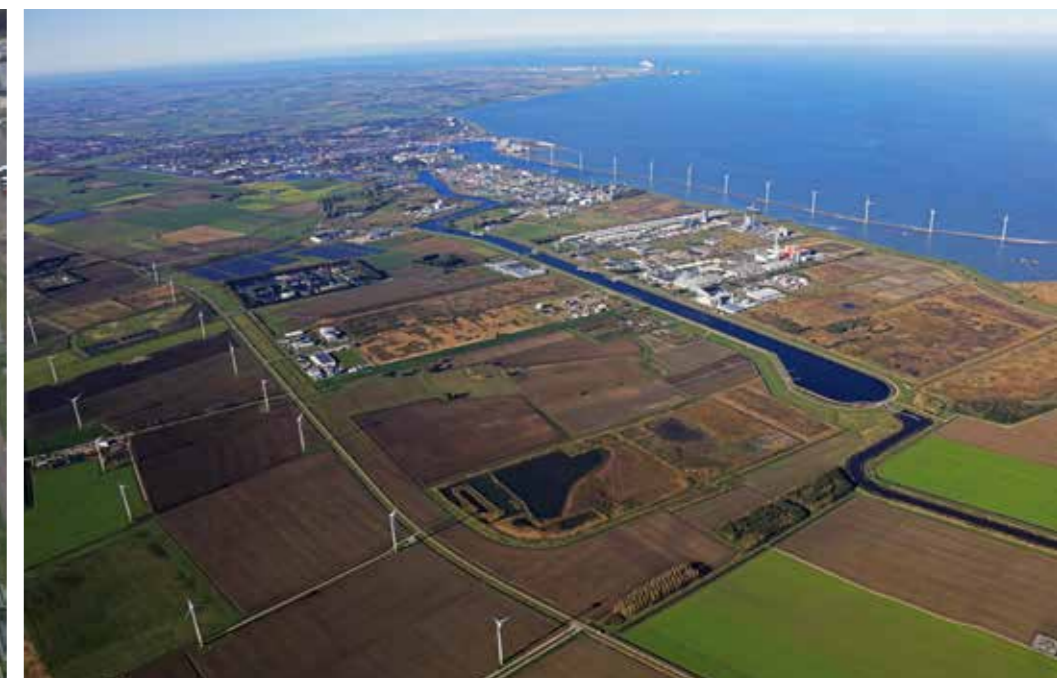
Delfzijl en Eemshaven vanaf 1000 meter hoogte
