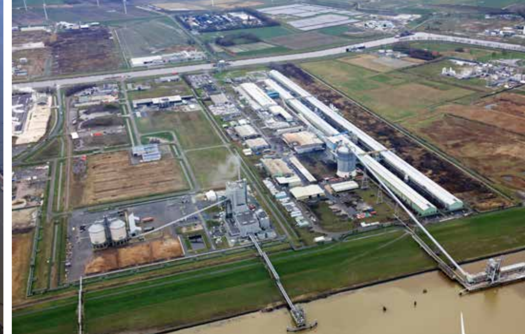
Metalpark DAMCO (Aldel) en Biocentrale Eneo
