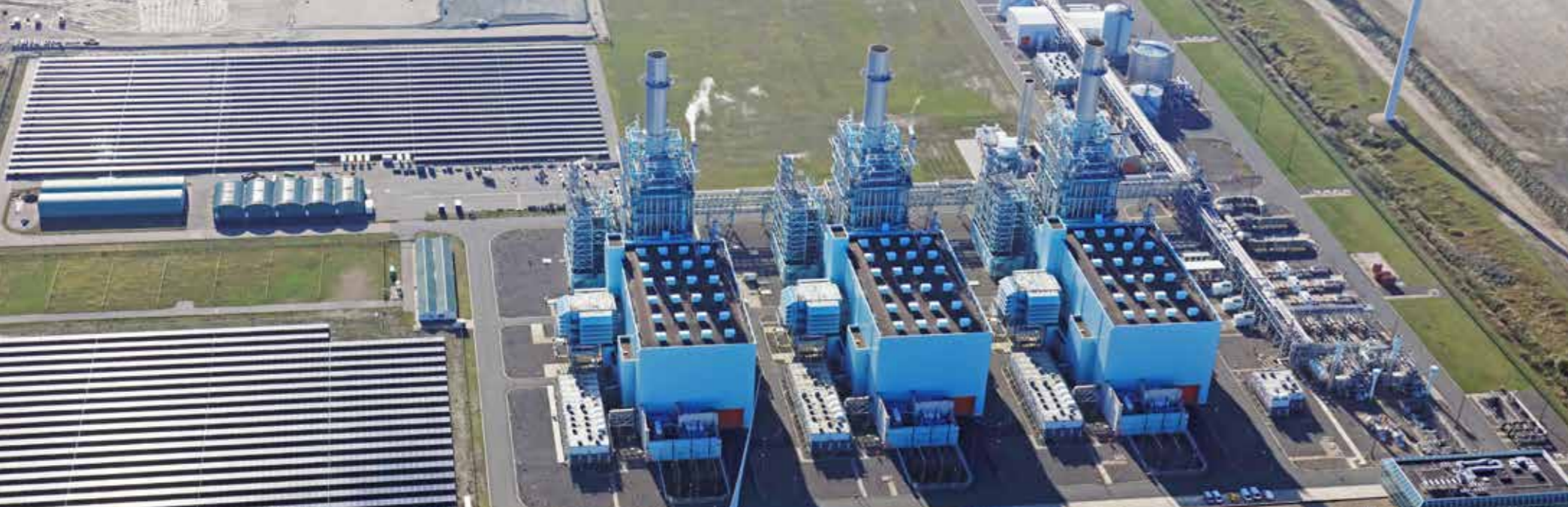
Nuon/Vattenfall Magnum energiecentrale
