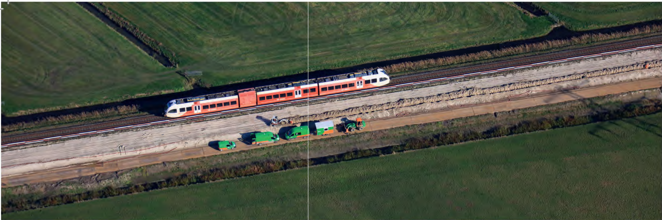
Aanleg dubbelspoor
