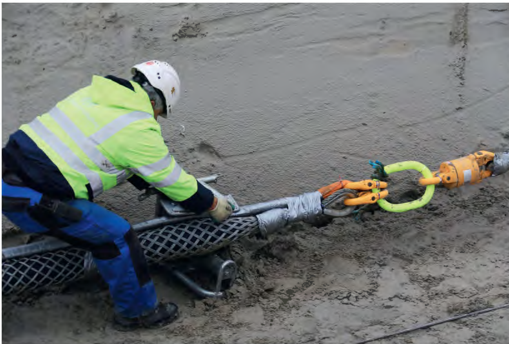
Voorzichtig trekken aan de kabel
