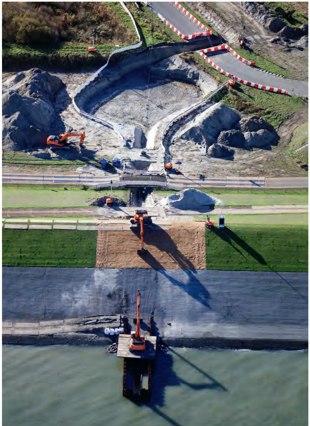
De kabel wordt aan land getrokken
