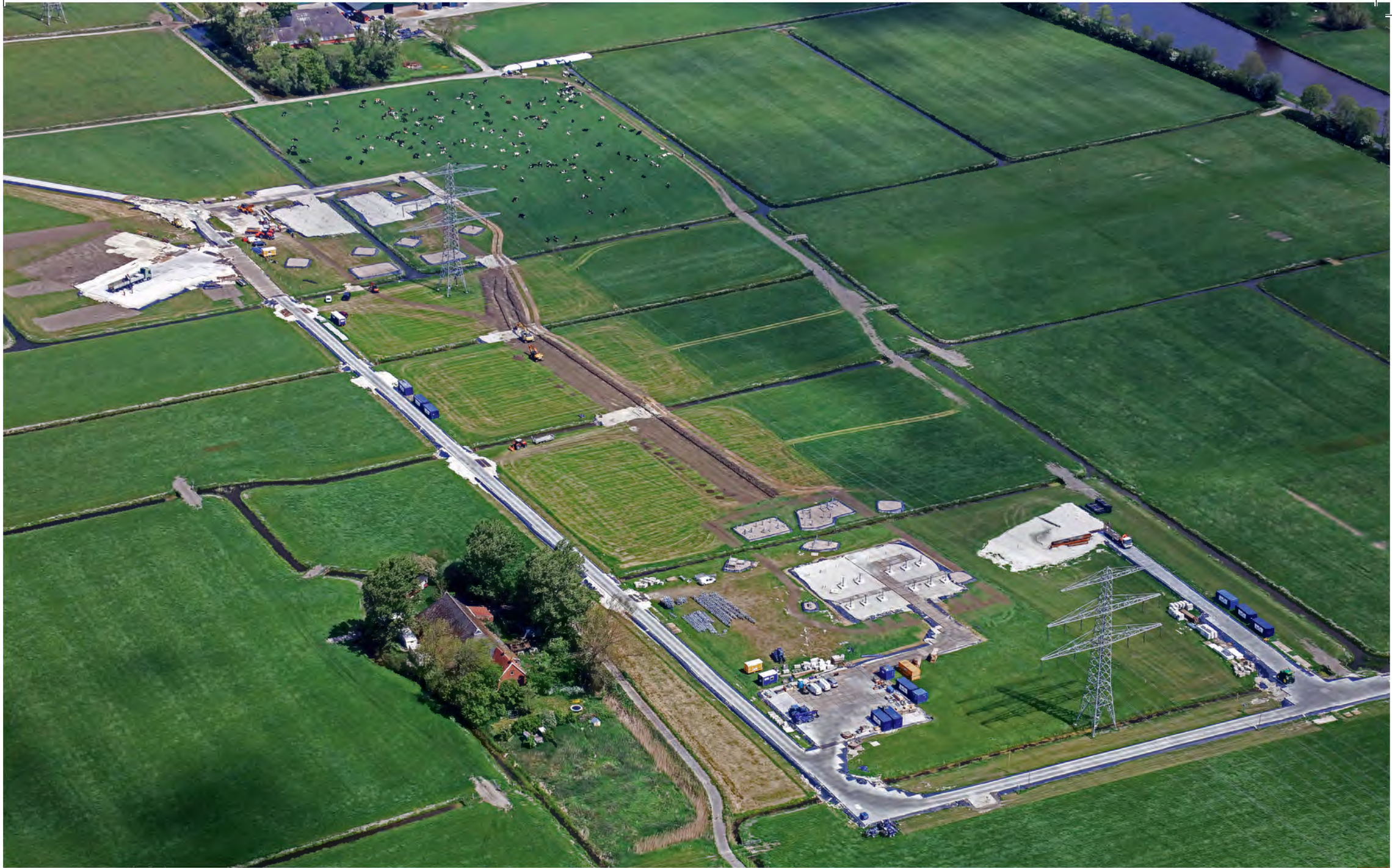
Werkterrein aanleg nieuwe 380 kV-verbinding tussen de Eemshaven en Vierverlaten
