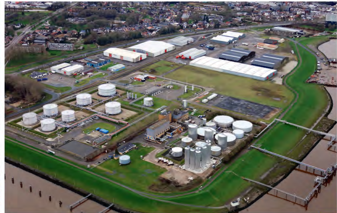
Tankopslag NAM en Contitank
