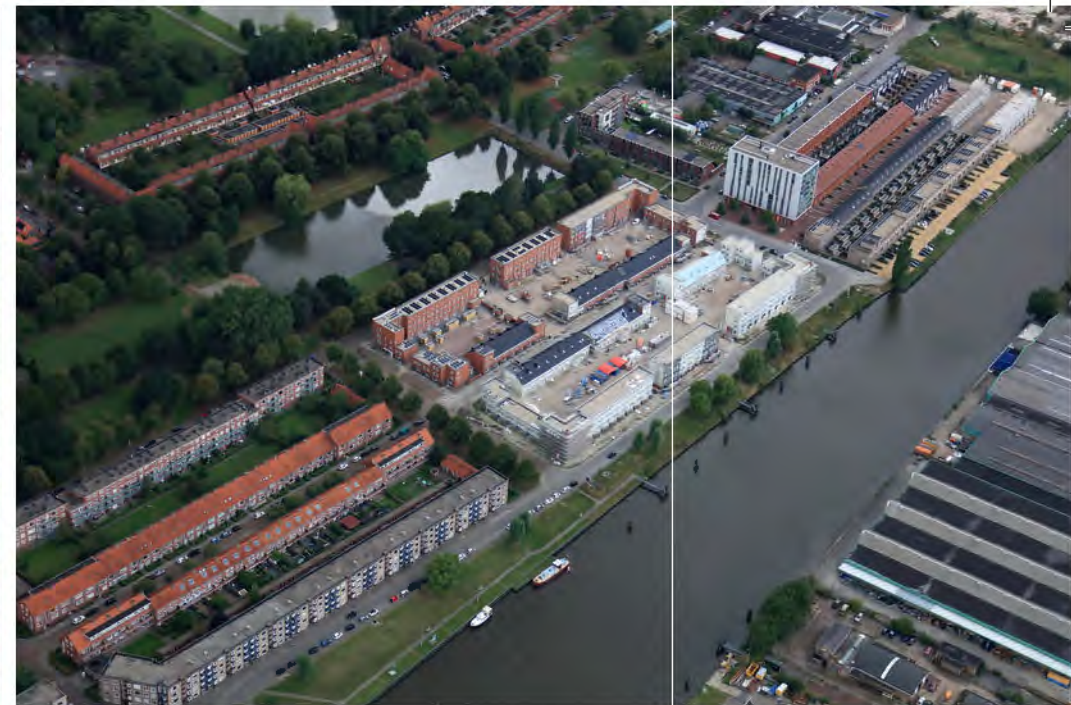
Nieuwbouw langs het Van Starckenborghkanaal
