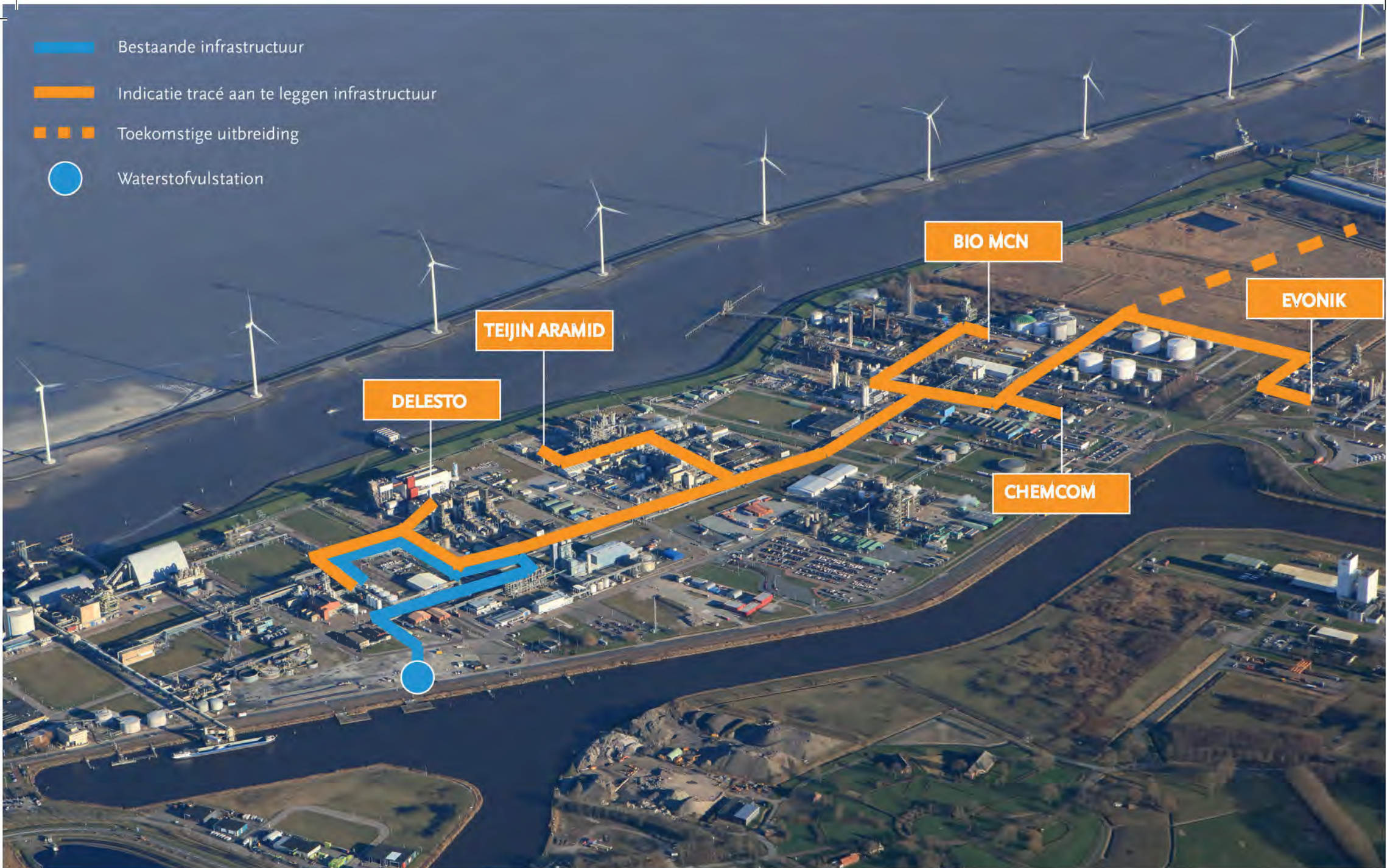
Waterstofinfrastructuur Delfzijl inclusief bedrijven en toekomstige uitbreiding ( www.pipelife.nl )
