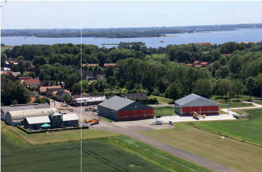
Hangars met kantine
