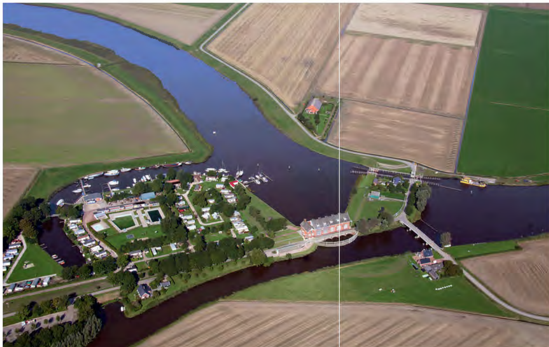
Gemaal De Waterwolf in Lauwerzijl
