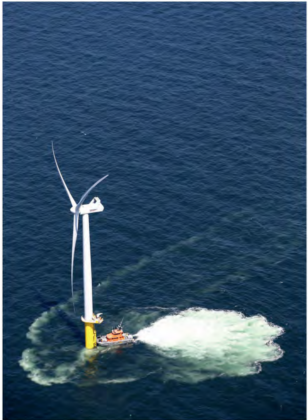
Onderhoudswerkzaamheden vanaf een transition vessel
