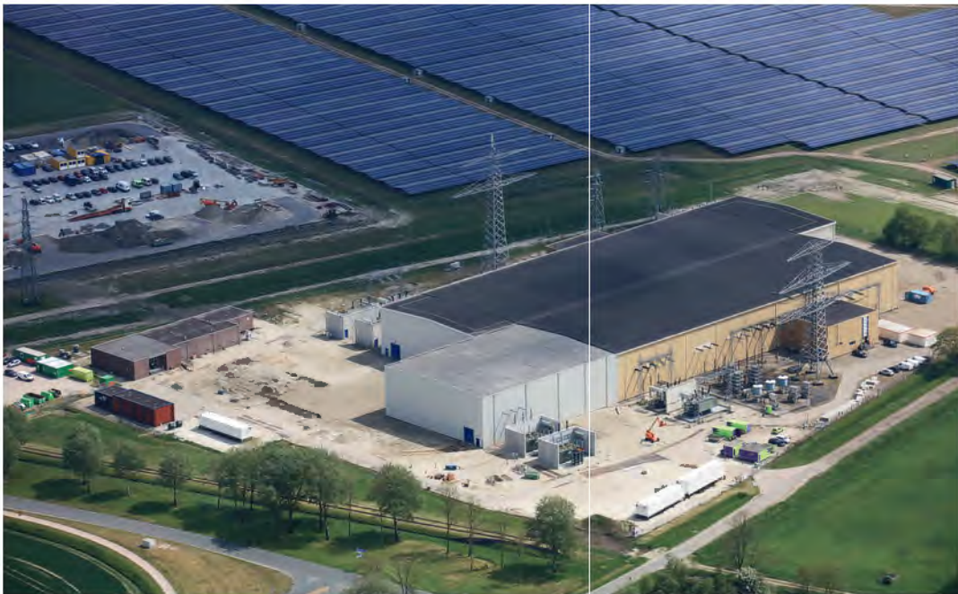
Uitbreiding hoogspanningsstation Delfzijl
