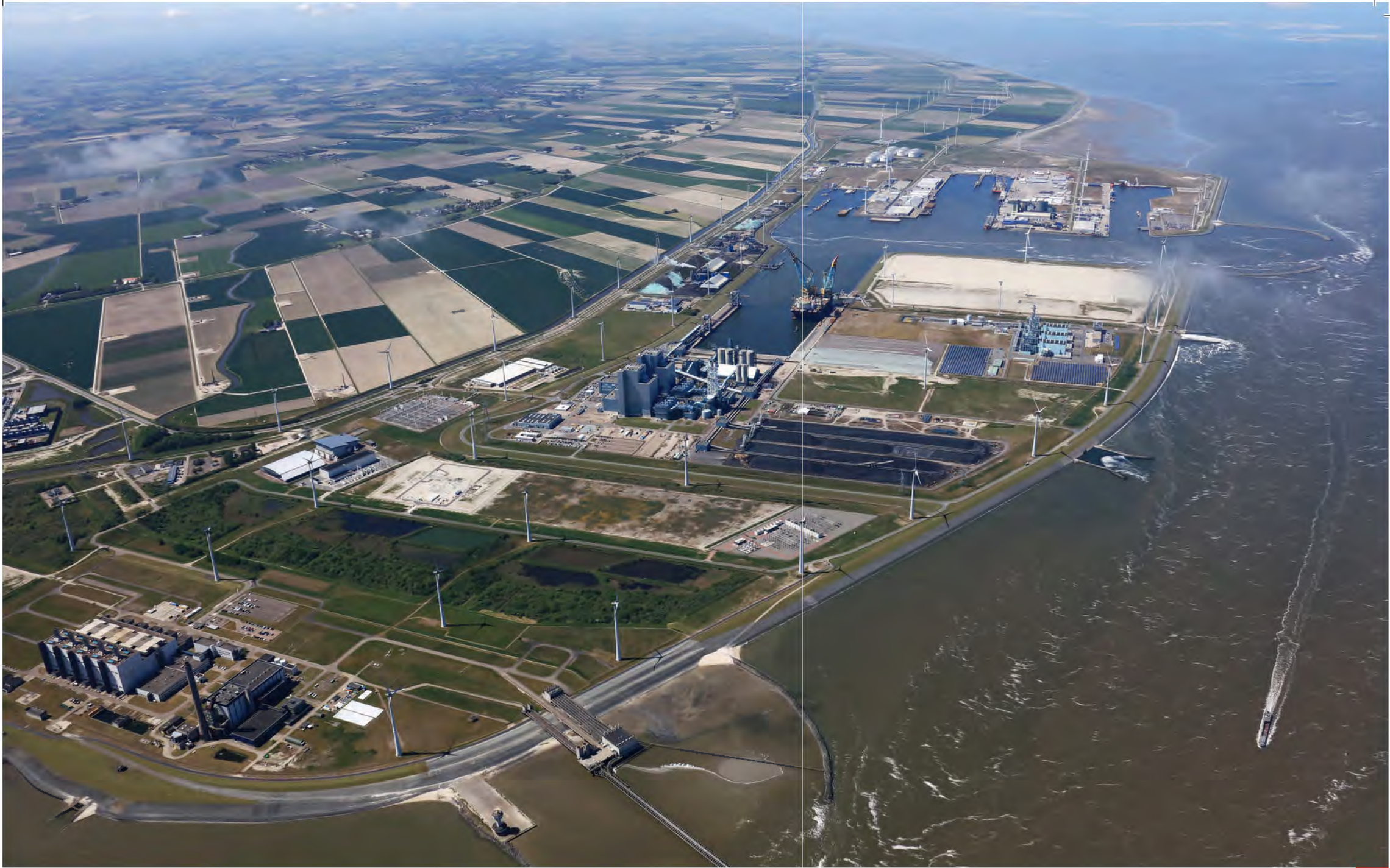
Energyport Eemshaven met de energiecentrales van ENGIE, RWE en Vattenfall
