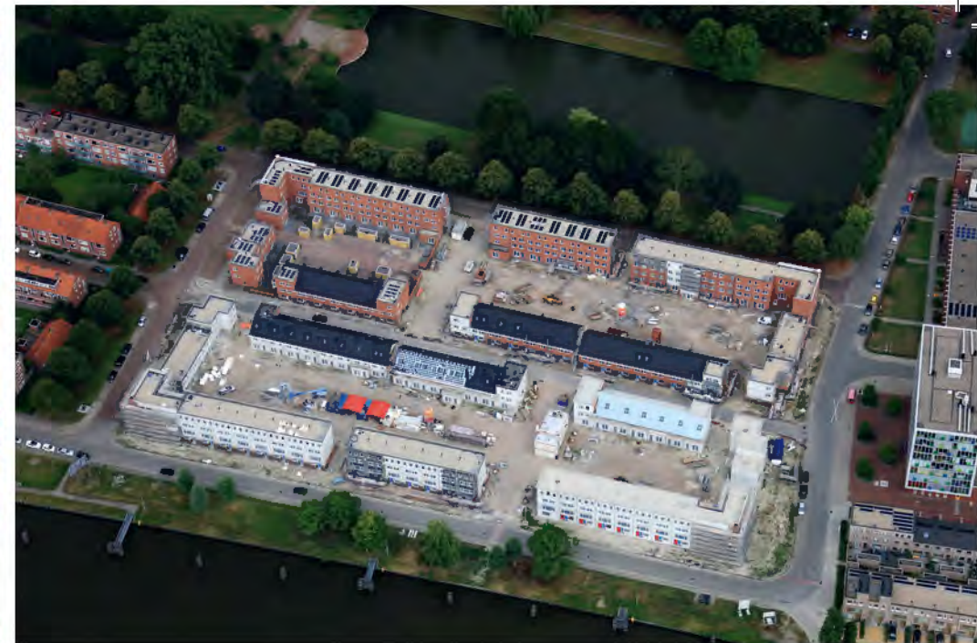
Nieuwbouw Oosterparkwijk langs het Van Starckenborghkanaal
