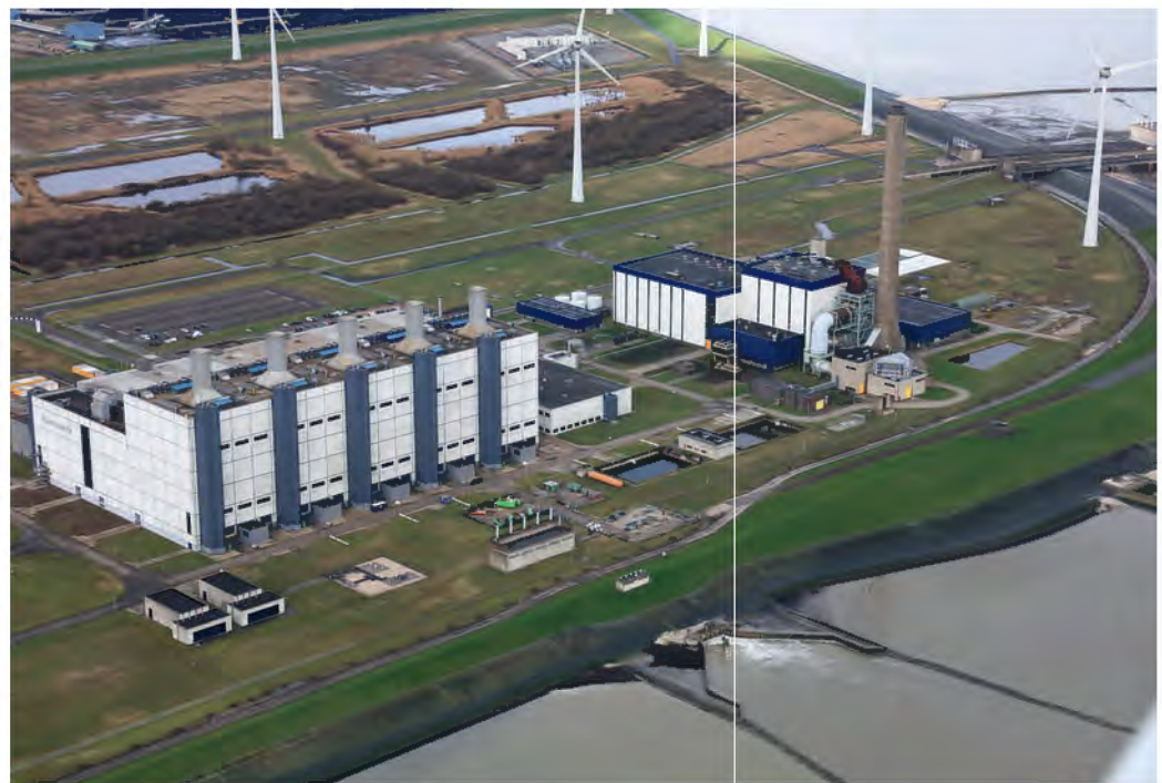
De Eemscentrale van ENGIE
