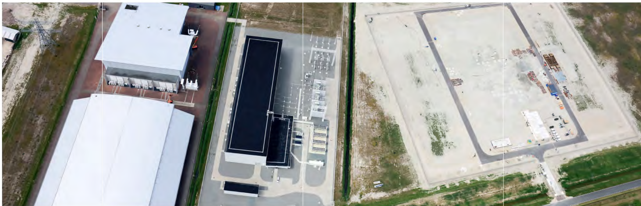
Converterstations in de Eemshaven voor NorNed en COBRA met bouwterrein: filter- en compensatiestation
