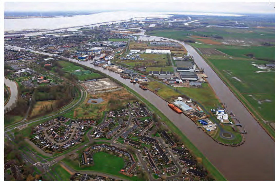
Eemskanaal Delfzijl - Groningen
