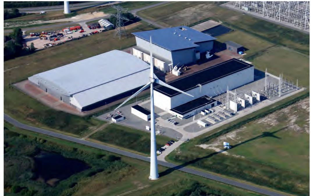
Converterstations van de NorNed- en COBRA-kabel
