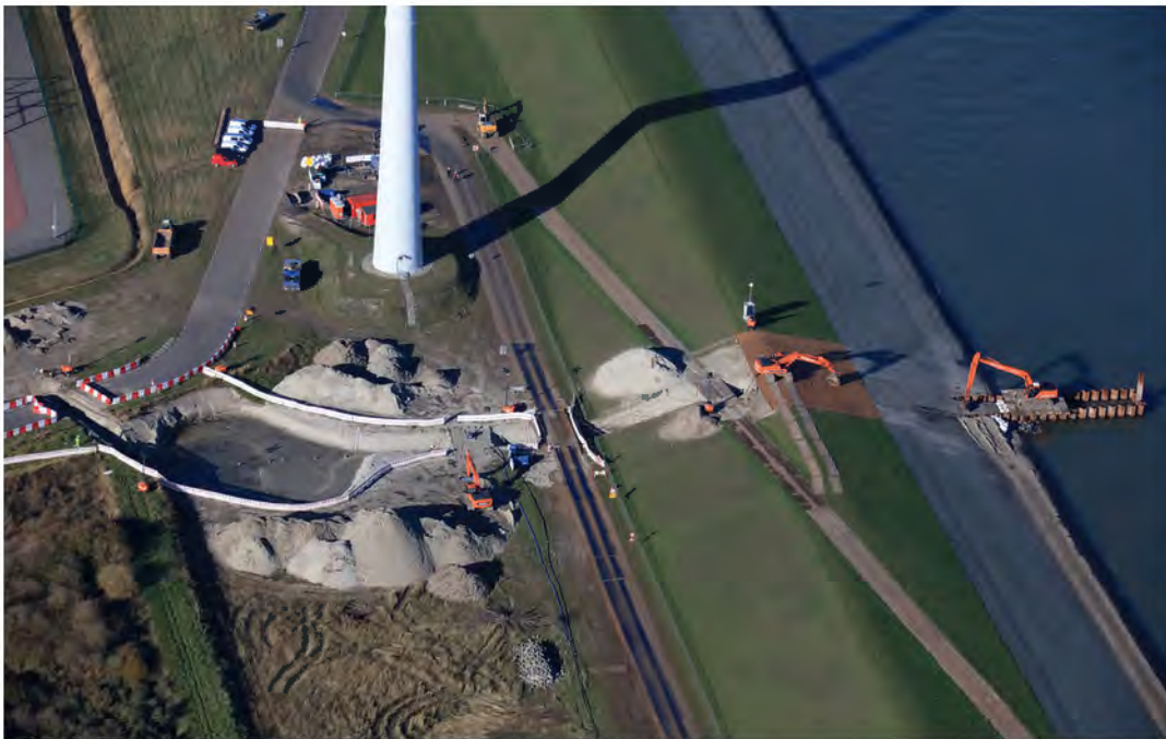
Doorvoer door de zeedijk
