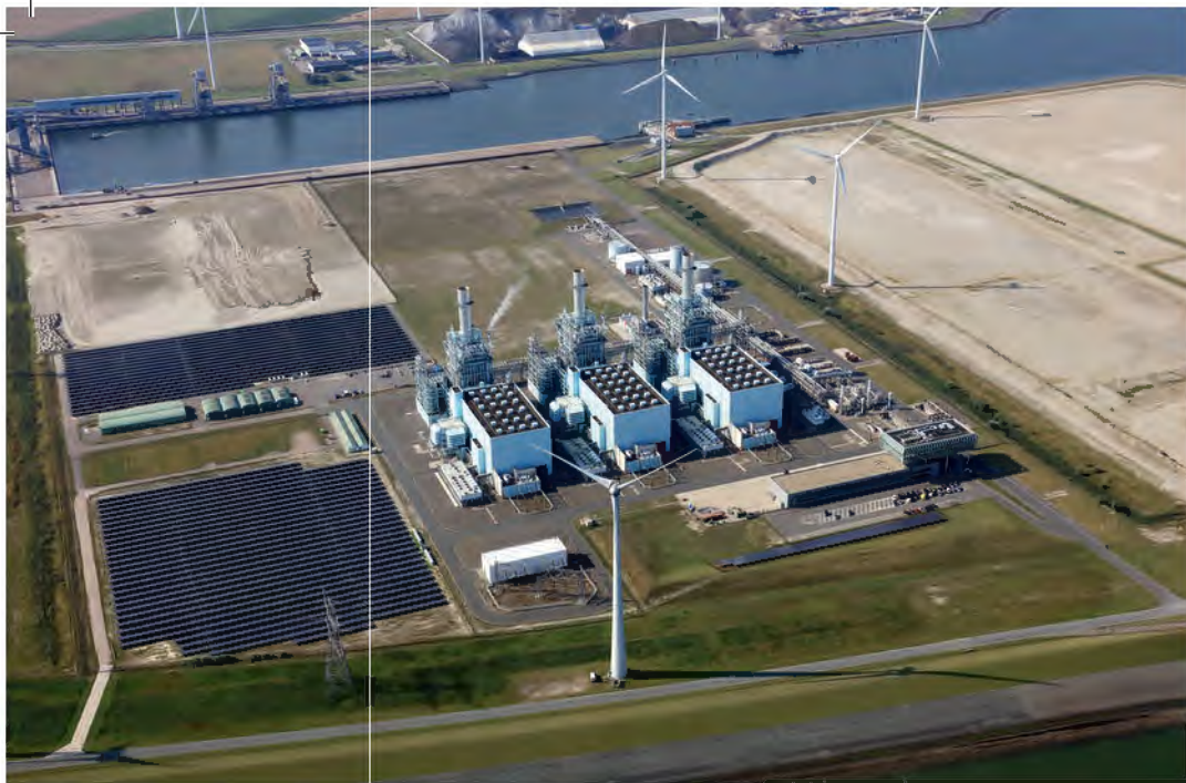
De Magnum-centrale van Vattenfall
