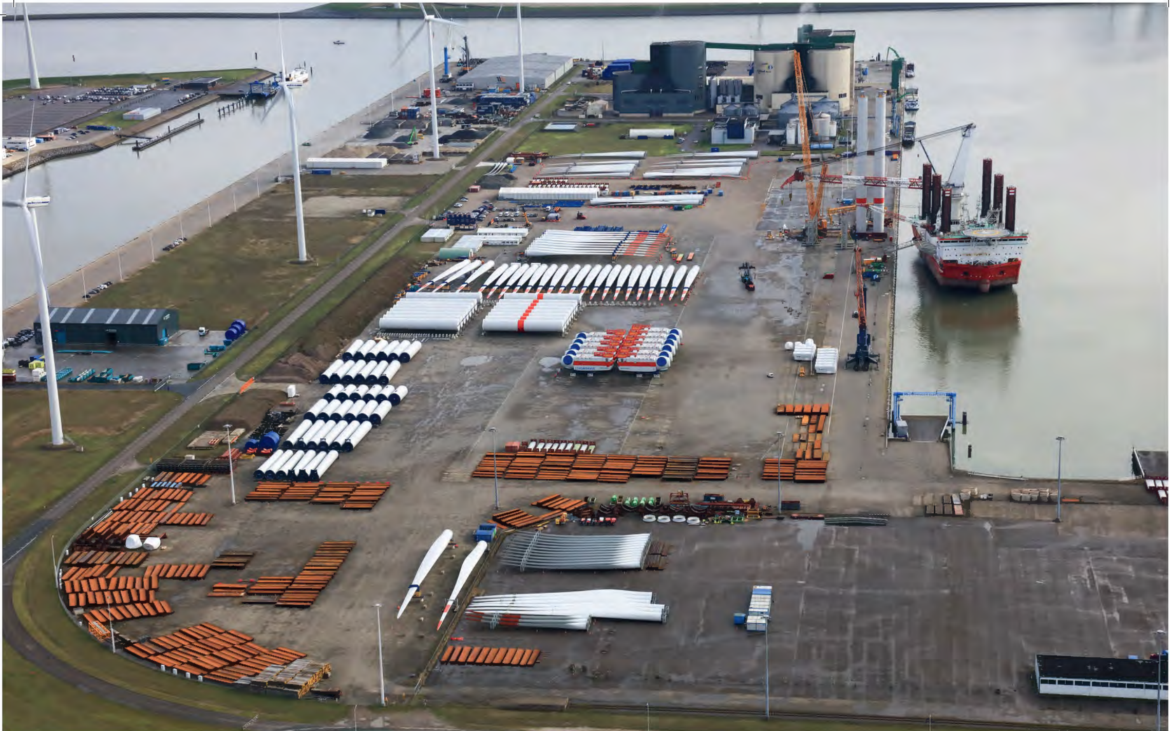
Buss Terminal Eemshaven: aanleg, installatie en logistiek offshore windparken
