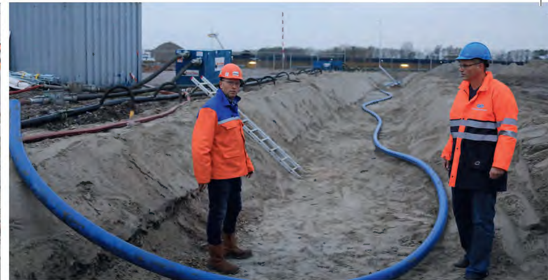
Aanleg van waterstofleiding op het Chemie Park door Pipelife
