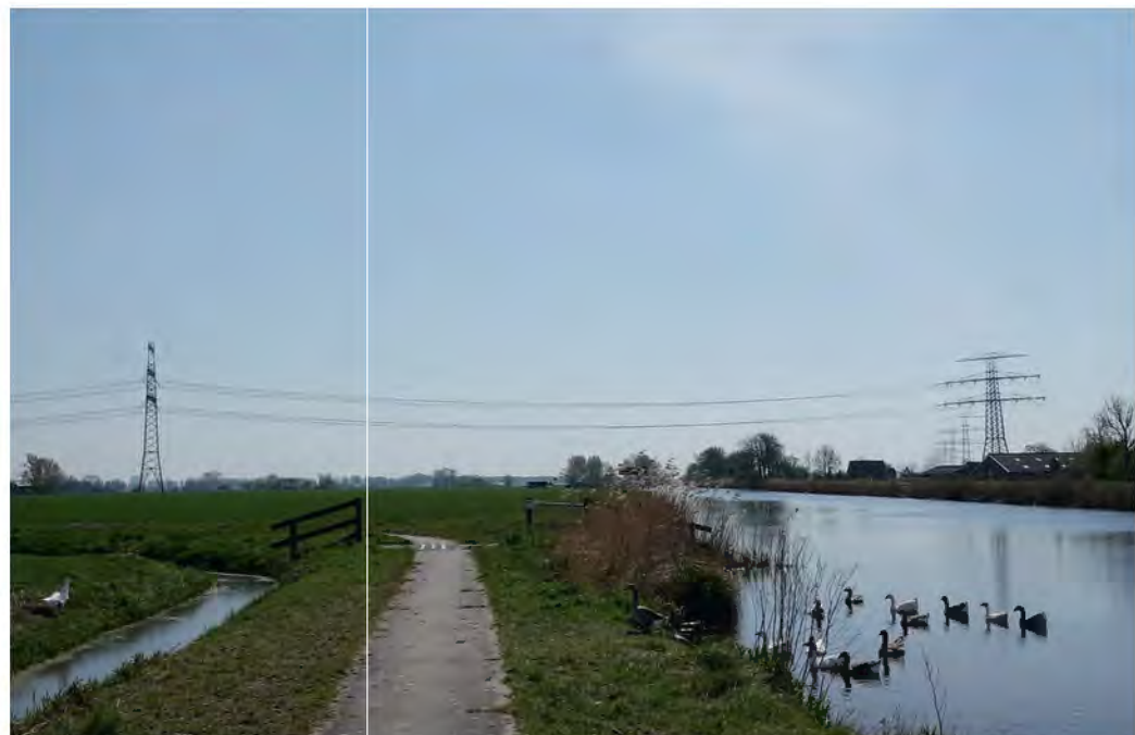
De 45 jaar oude 220 kV-verbinding maakt binnenkort plaats voor een 380 kV-verbinding: Brilllerij
