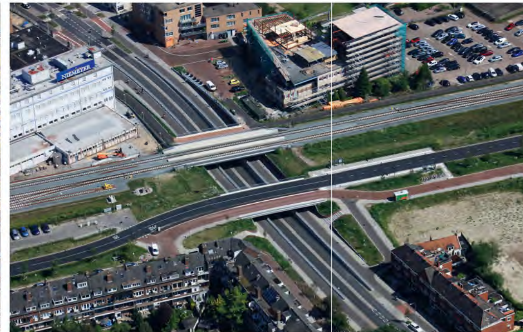
Tunnel Paterswoldseweg bij Niemeyer BV, 23 juni 2020
