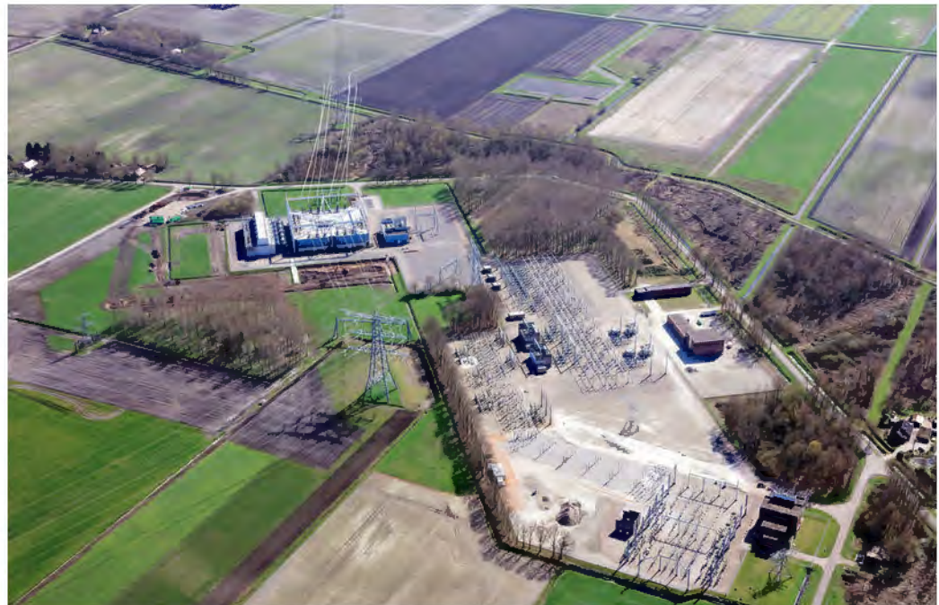
Uitbreiding hoogspanningsstation Meeden
