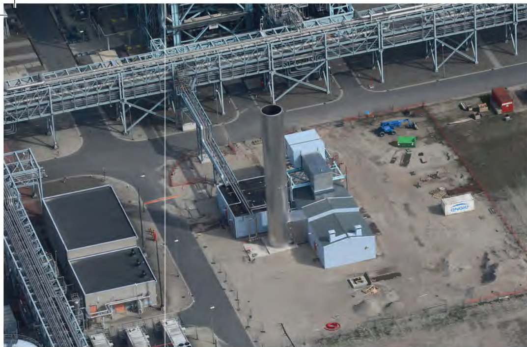
Black-start-centrale van Vattenfall voor TenneT
