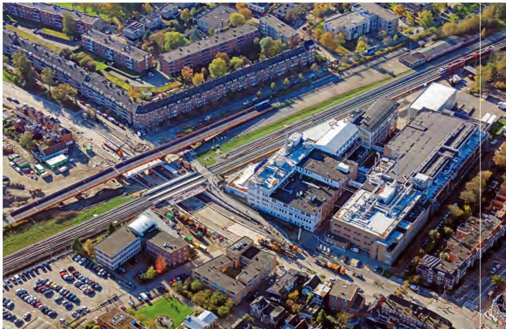
Tunnel Paterswoldseweg bij Niemeyer BV, 30 oktober 2019
