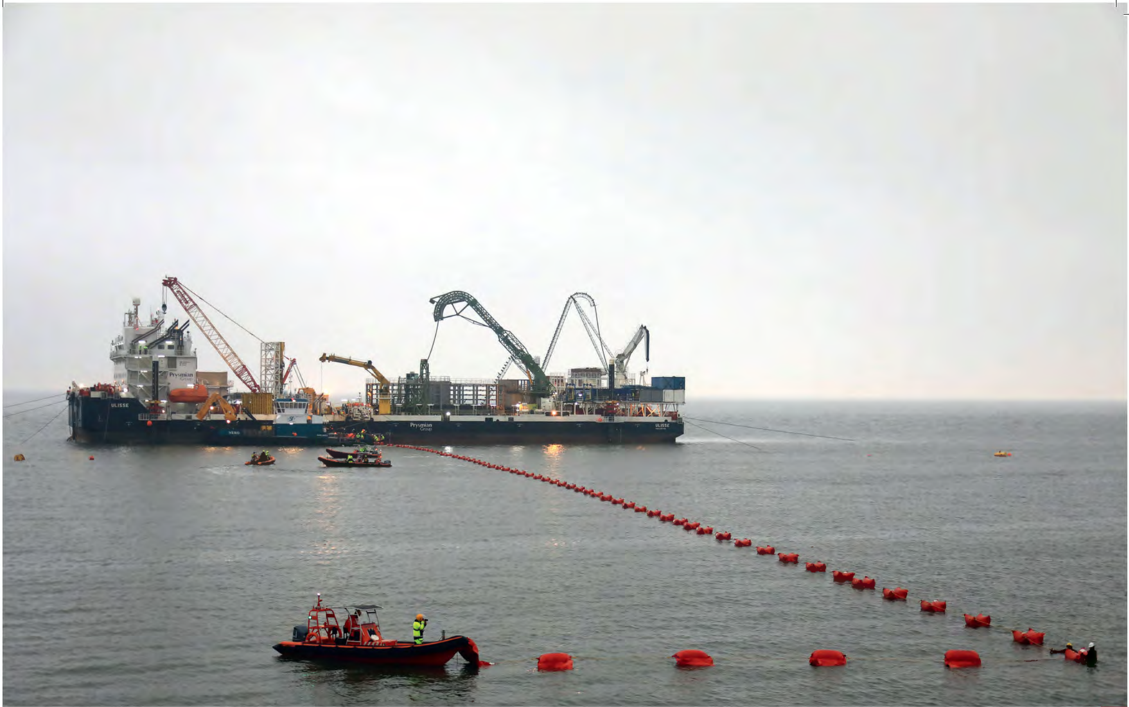
De kabel drijft op luchtkussens
