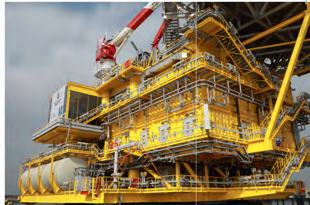
Transformator voor een windpark
