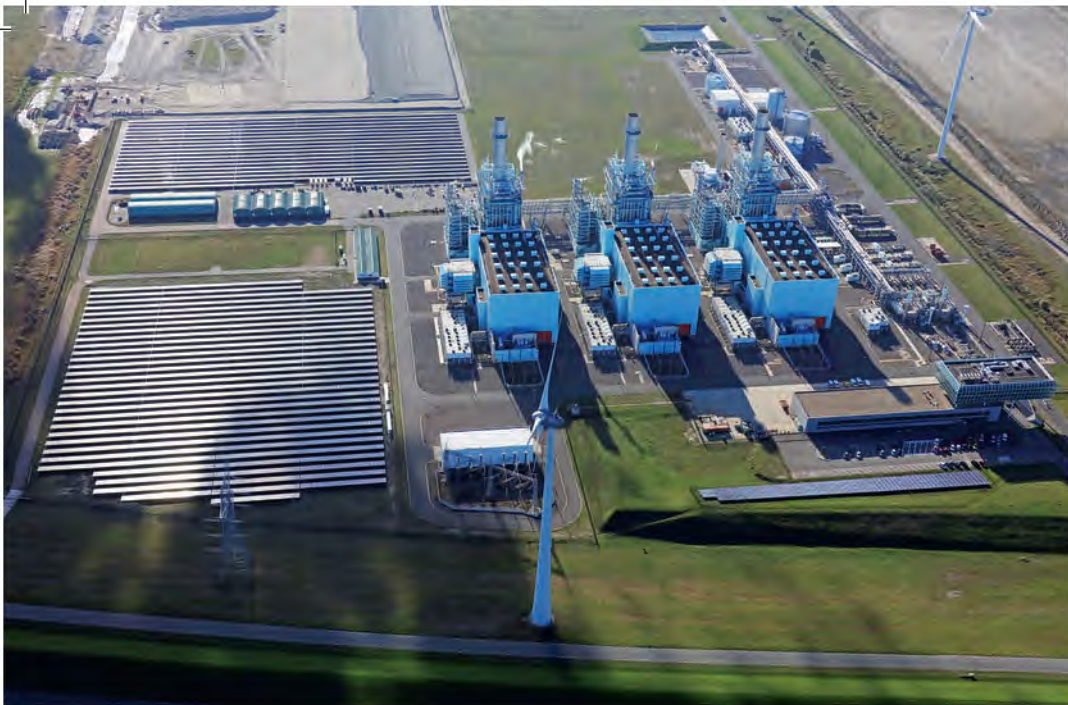
De Magnum-centrale van Vattenfall
