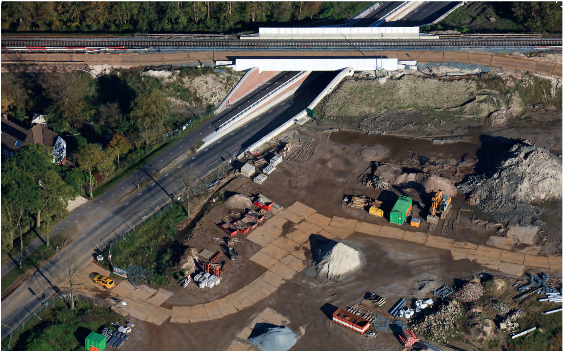
Spoorbrug Fanerweg bij Zuidhorn
