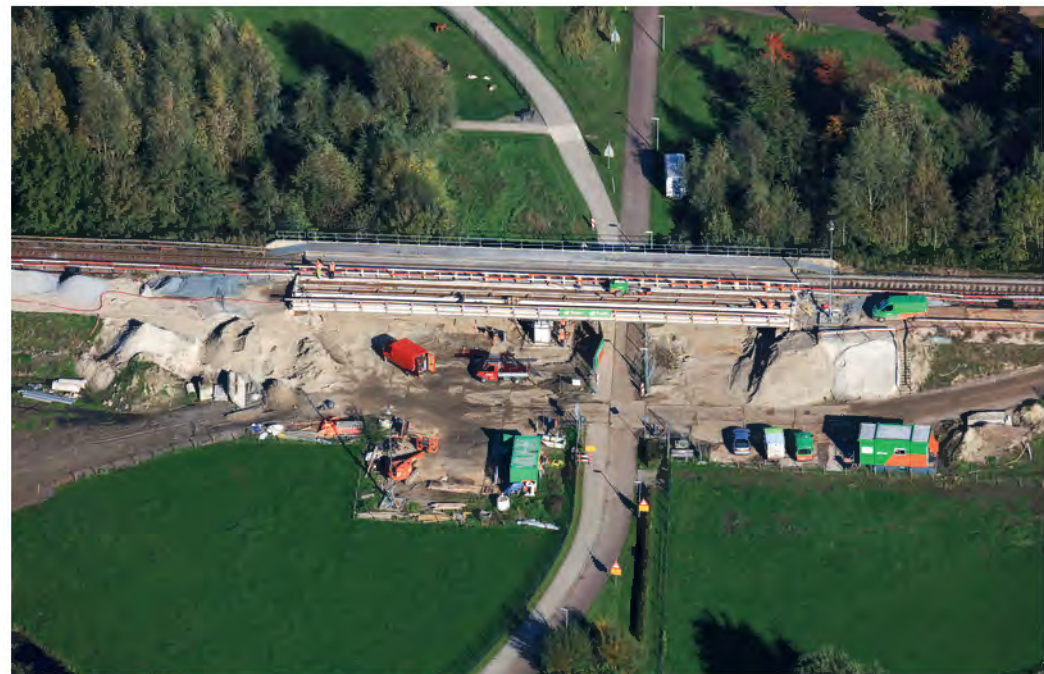
Fietsonderdoorgang Wilhelminapark bij Zuidhorn
