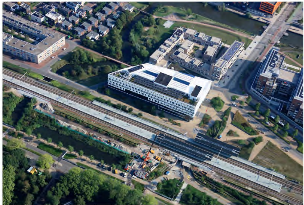
Station Europapark aanleg extra spoor
