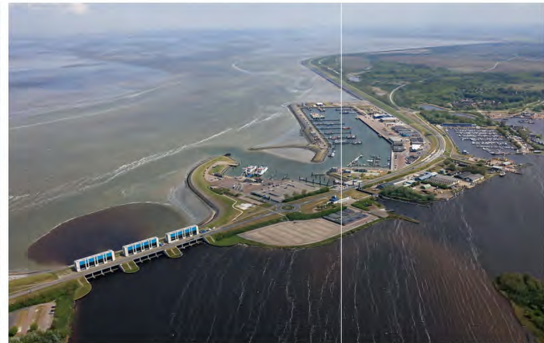
De R.J. Cleveringsluizen zijn spuisluizen
