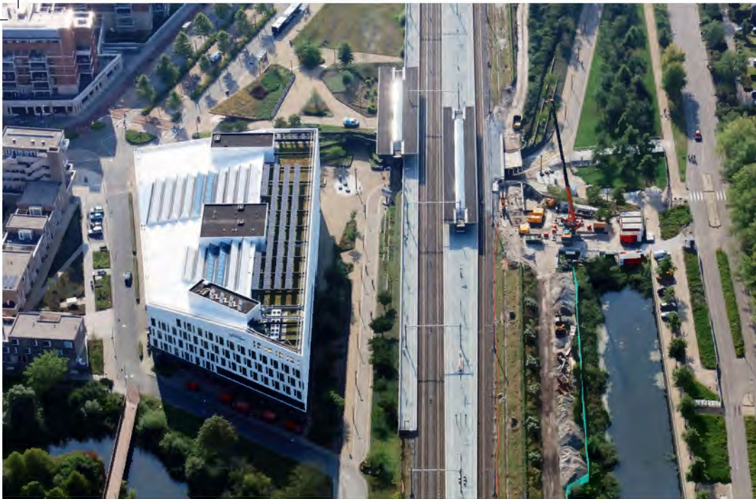
Station Europapark aanleg extra spoor
