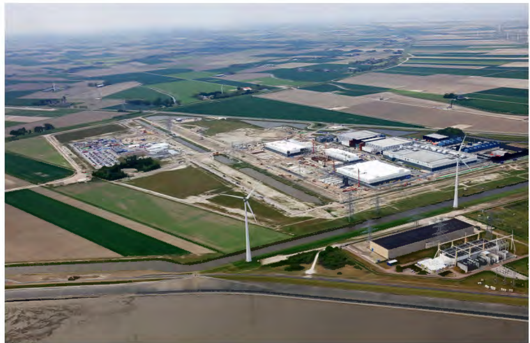
Google Eemshaven uitbreiding datacenter, 18 mei 2020
