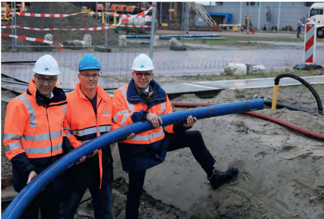
Aanleg van waterstofleiding op het Chemie Park door Pipelife
