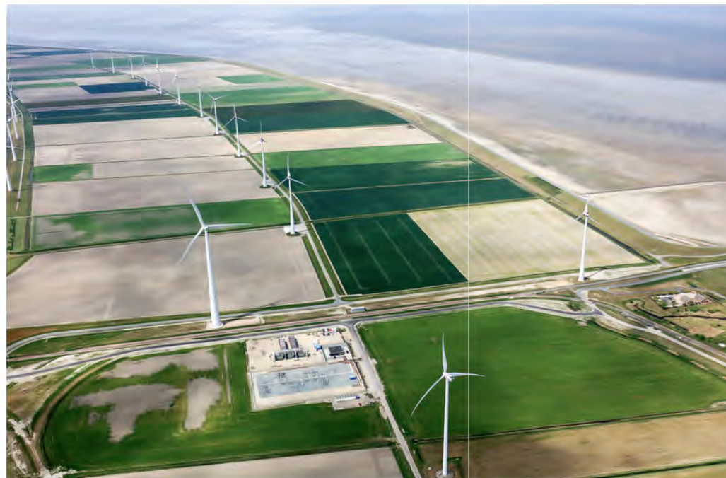
Hoogspanningsstation in aanbouw aan de Middenweg, Eemshaven, 18 mei 2020
