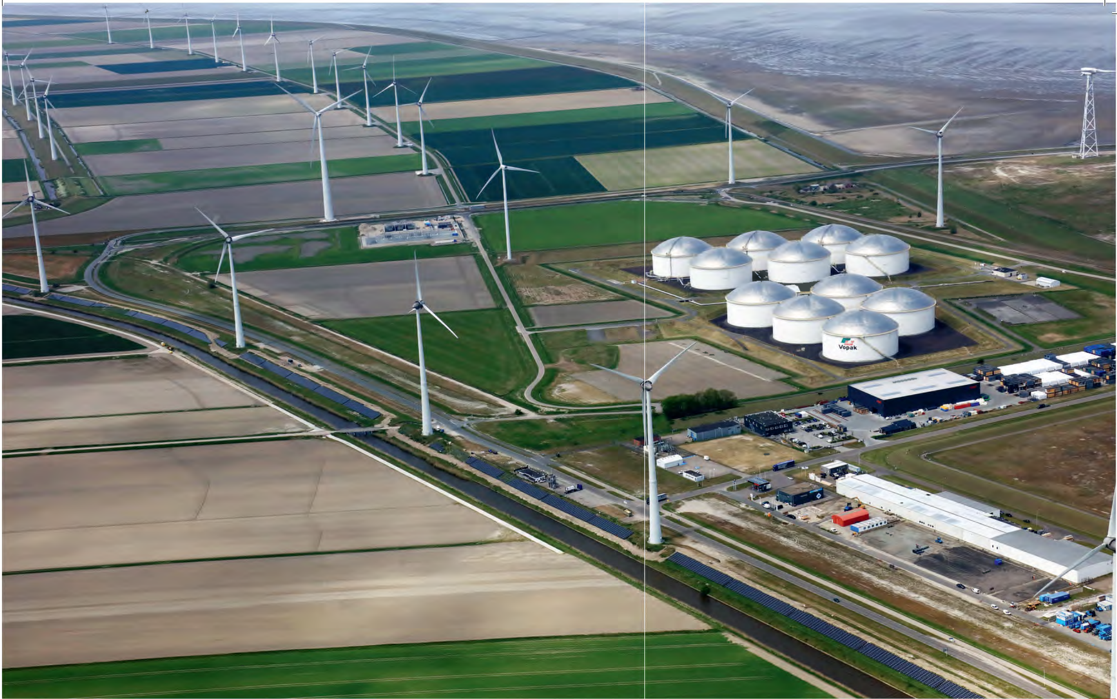
Energieopwek, opslag en transport in de Eemshaven
