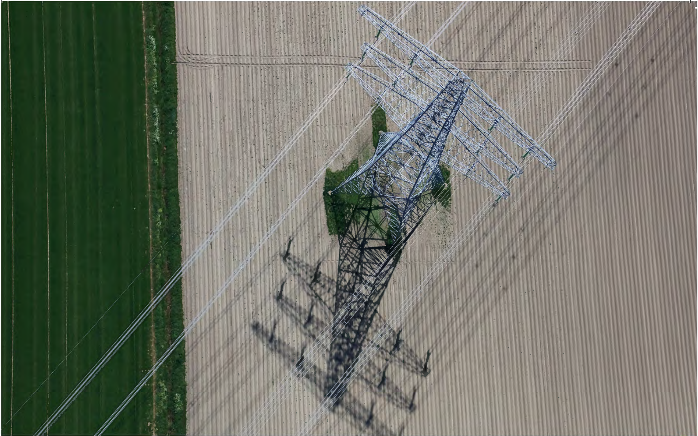
Hoogspanningsmast op het Hogeland
