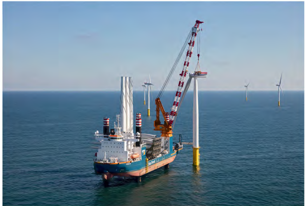
Montage van een generator op de windmolenmast
