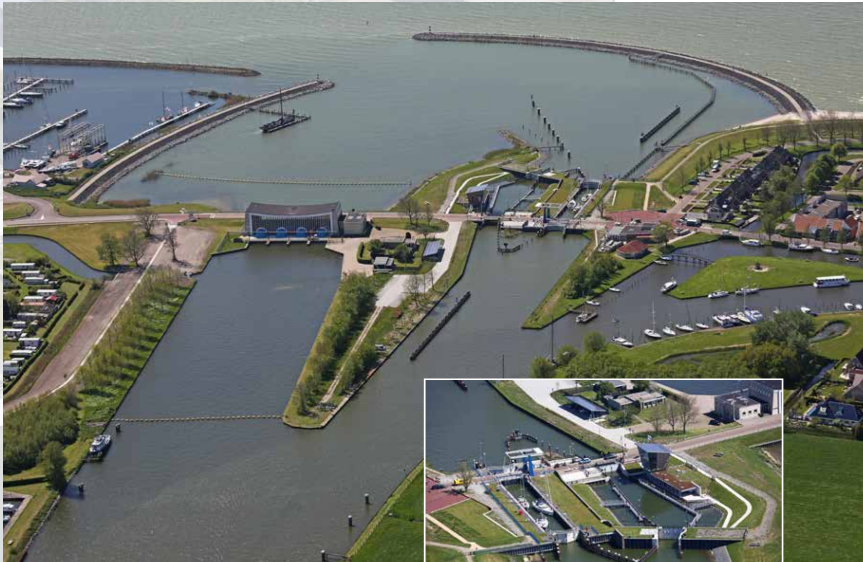
▲ Gemaal en sluis Stavoren
